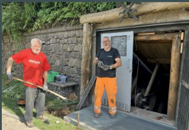
Der Schaustolleneingang wurde überschwemmungssicher gemacht
