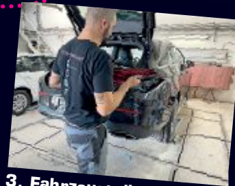
3. Fahrzeugteile werden zur Reparatur abgebaut
