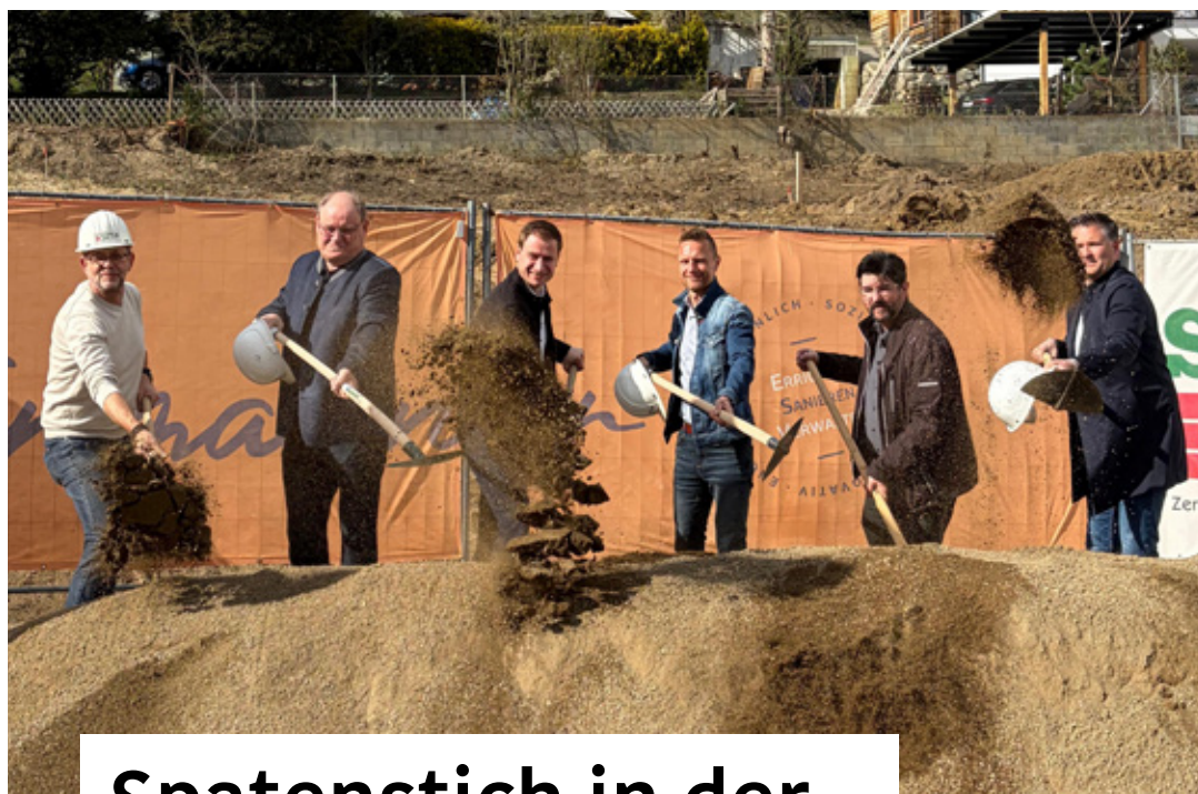
Spatenstich in der Winter- bachgasse 4 in Fohnsdorf
