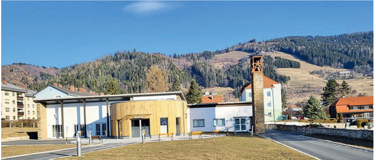
Die Bestattung der Gemeinde Fohnsdorf mit dem Verwaltungsgebäude und der neu errichteten Verabschiedungshalle sorgt für eine würdevolle Verabschiedung.
